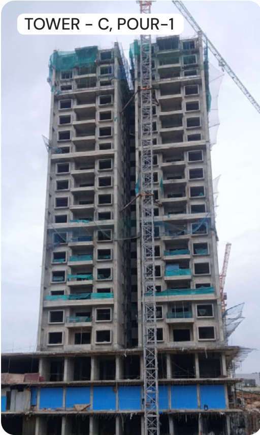
TOWER - C, POUR-1,2
